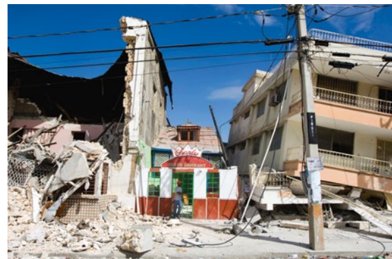
Daños en el distrito comercial, Puerto Príncipe.
