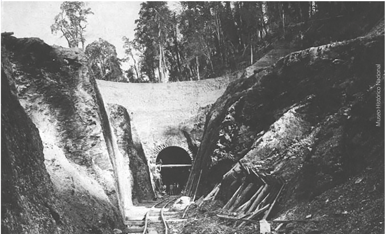
📍 (S. i.). (1910). Construcción de túnel ferroviario en la frontera.
