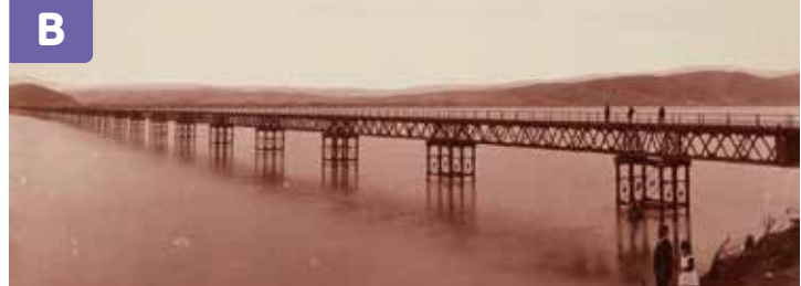
Fotografía del Puente Ferroviario Bío-Bío de Concepción (1900), inaugurado en 1889.
